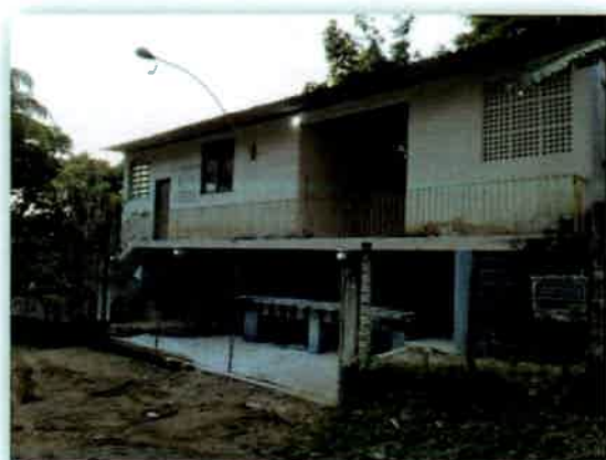
Condições iniciais da unidade de Tratamento localizada no Mazomba
