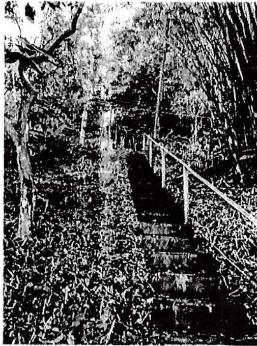
Escada acesso a captação
